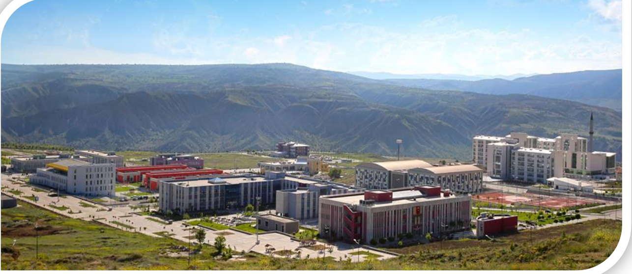
Şekil 4. Uluyazı Yerleşkesinden Bir Kesit.
