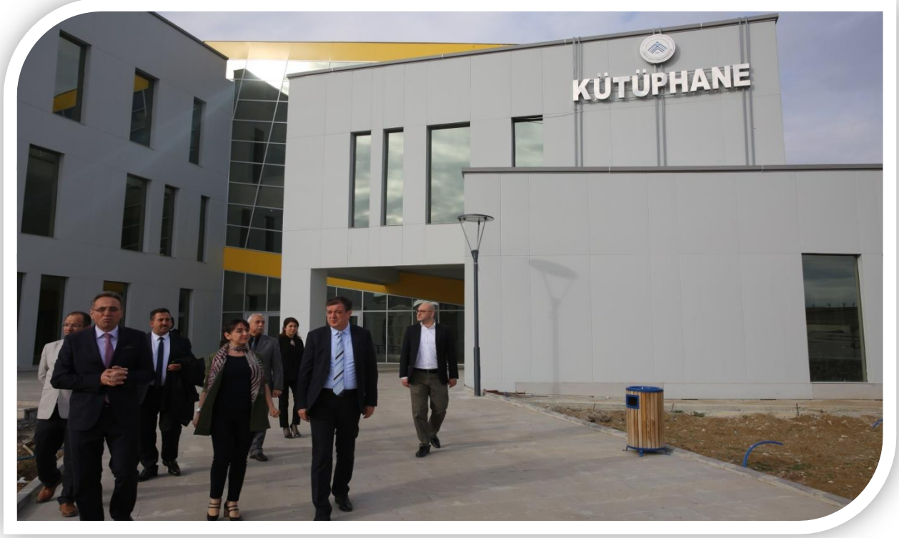
Şekil 6. Üniversitemiz Kütüphane Binasından Bir Kesit.
